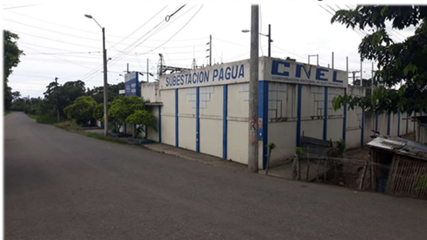
Gráfico 5.9. Subestación eléctrica Pagua
