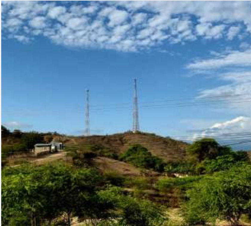
Foto 10. Infraestructura de telecomunicaciones instaladas por las operadoras Movistar y Claro – Comuna Bambil Collao
