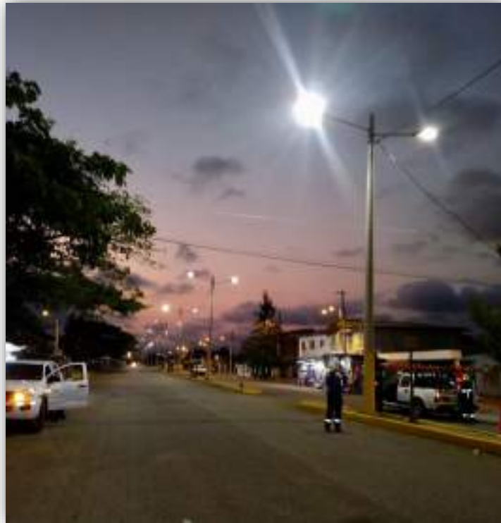
Foto 9. Instalación del sistema de iluminación con tecnología Led
